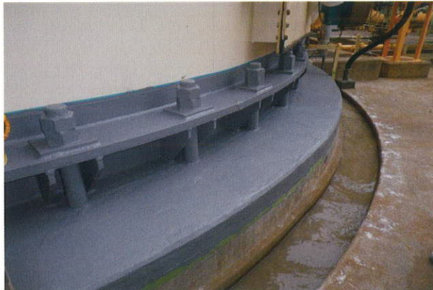
沖縄県 (タンク周り)
