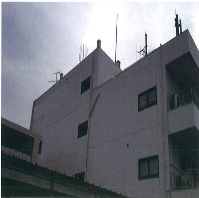
市役所壁面改修現場
