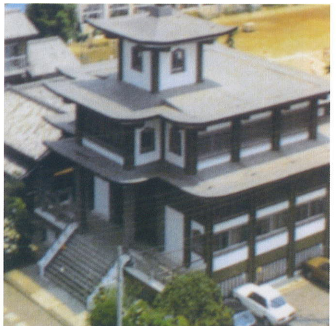
寺社屋上防水改修
