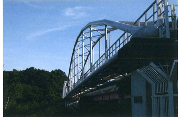
北海道 (水管橋)
