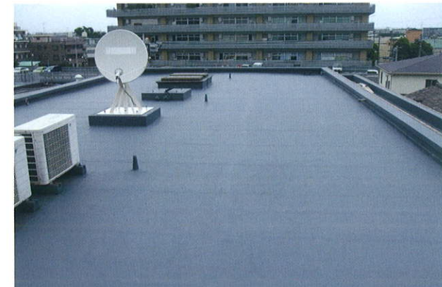
東京都 (陸屋根シート防水改修)
