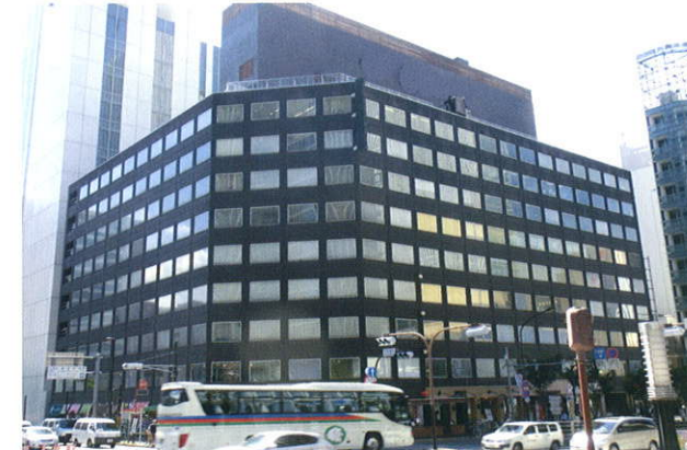
東京都 東銀座(昭和57年施工 ビル外壁)
