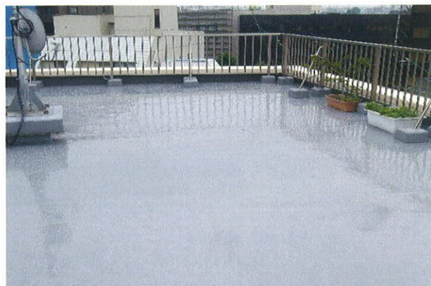
東京都 (陸屋根コンクリート防水 脱気孔無し)
